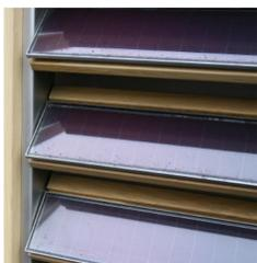
Strom wird über die **Photovoltaikmodule** auf den **beweglichen Lamellen** der Südwest-Fassade erzeugt. Diese Lamellen werden der Sonne automatisch nachgeführt, können jedoch auch manuell gesteuert werden, da sie gleichzeitig als **außenliegender Schutz vor Überhitzung und Blendschutz** dienen.
